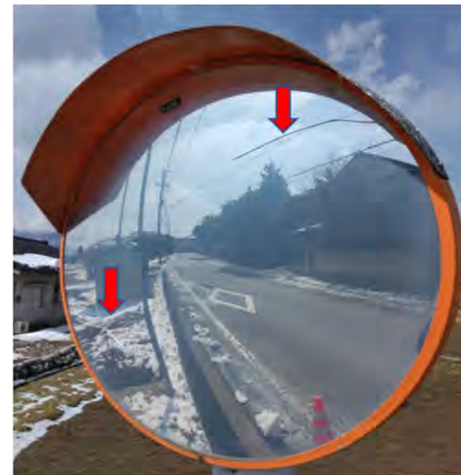
図1 交換前(鏡面の曇りとひび割れ)
