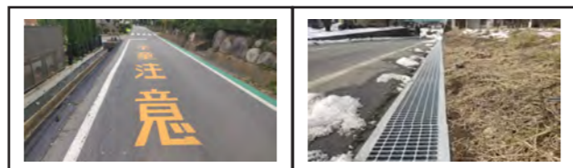
図6 警戒標識（左図※2）グレーチング設置（右図※3）
