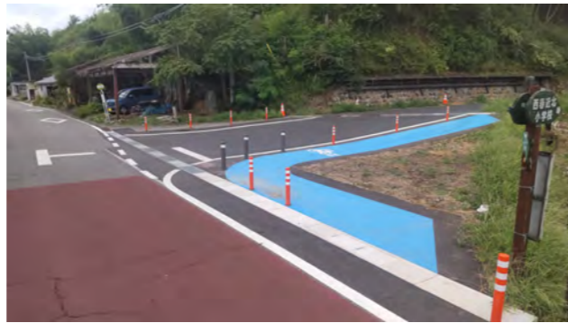
図3 交差点改良（伊那市西春近戸沢橋付近）
